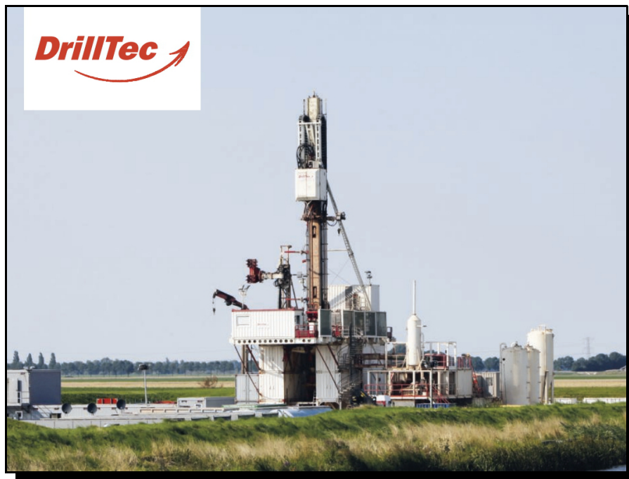
Figur 4 Den store borerig i arbejde et andet sted
